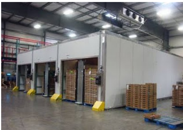
Una camera di raffreddamento per la frutta all'interno di un magazzino
